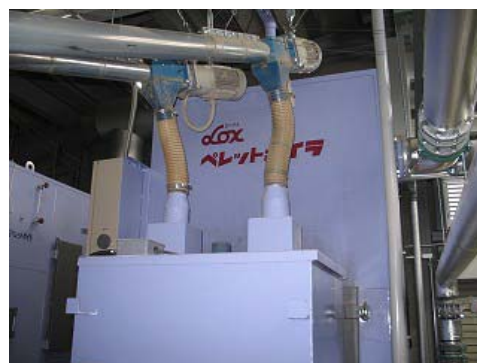
写真Ⅱ-5.3-2 リザーブタンク
