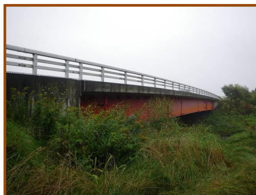
第2晩翠橋 (橋長 43.60m) 昭和 61 年供用開始
