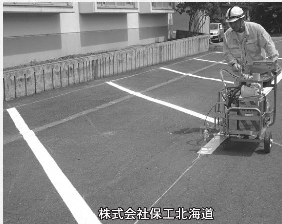
▼町立南幌病院駐車場区画線布設
