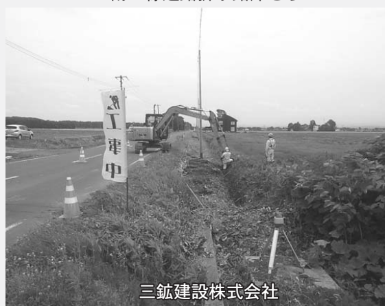
▼南10線道路排水路床ざらい
