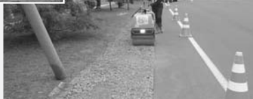
南幌中学校校門通路脇▶ 排水溝補修
