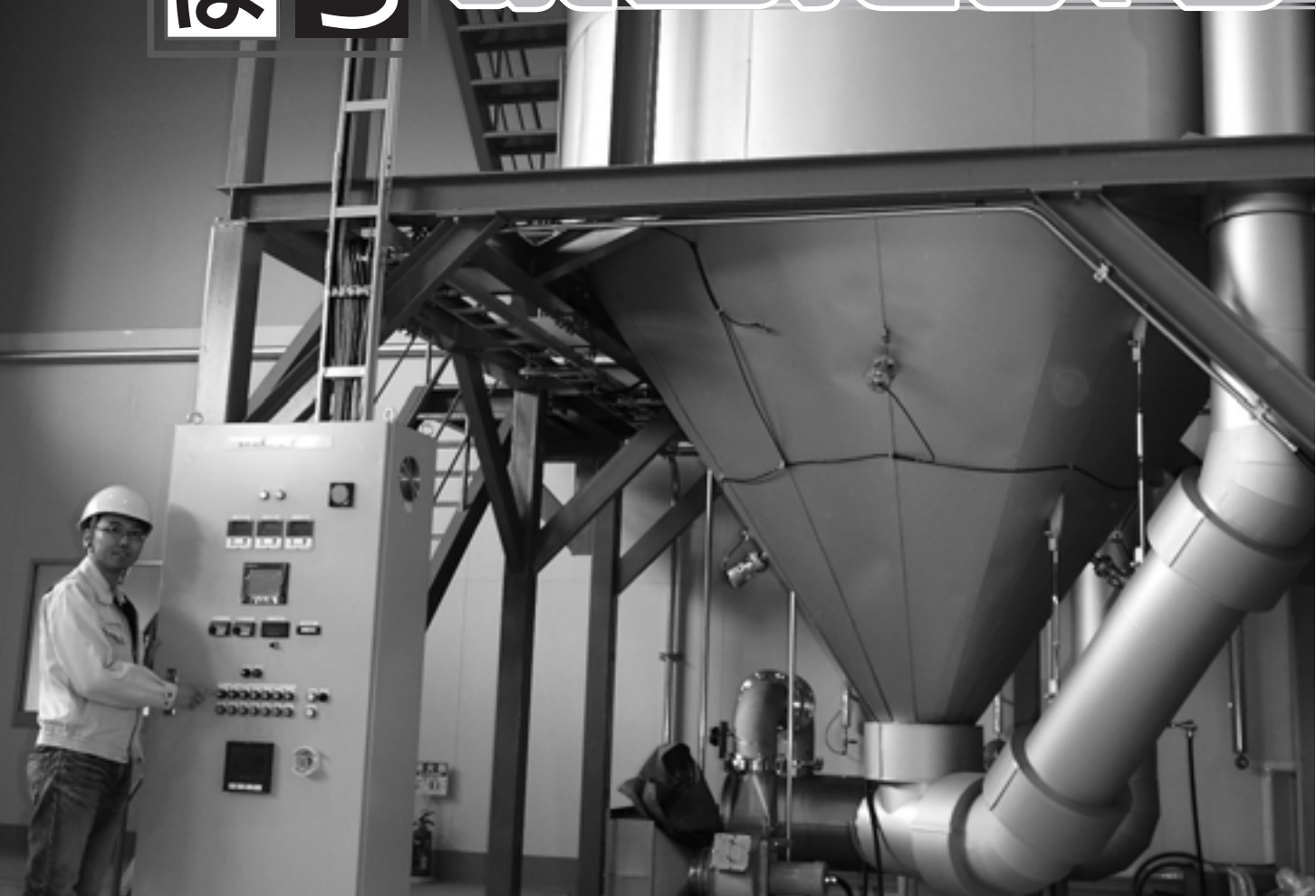
日生バイオ(株)北海道工場 試験操業始まる! 写真はスプレードライヤー(噴霧乾燥器)
