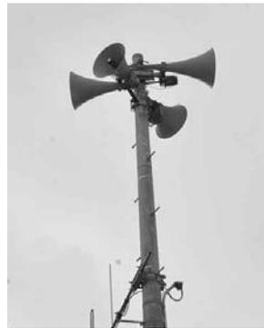
防災行政無線は老朽化が進んでいることから、本年度、デジタル防災行政無線への更新工事を行い、加えて、全世帯に戸別受信機を設置し、緊急時に迅速かつ安定的な情報を伝達すべく、平成29年4月の運用開始を目指します。
