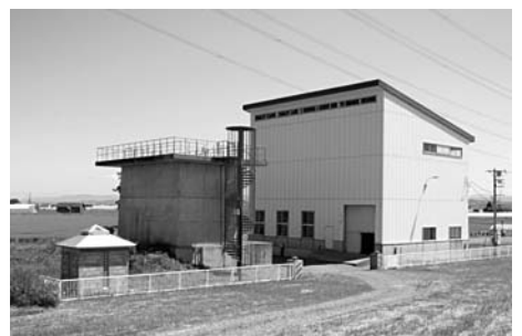
幌向揚水機場
