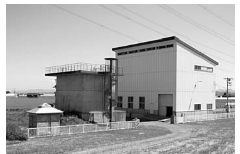
幌向揚水機場
