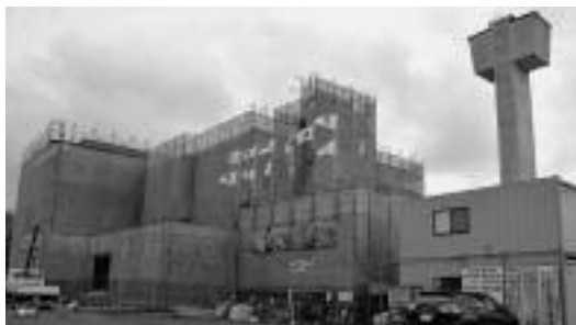
生涯学習センター（旧南幌小学校） （外壁耐震工事）
