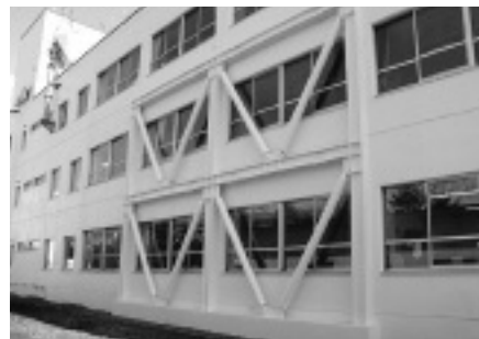
庁舎耐震改修工事
