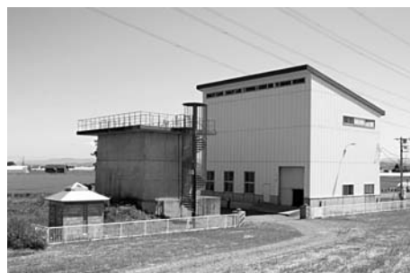
幌向揚水機場
