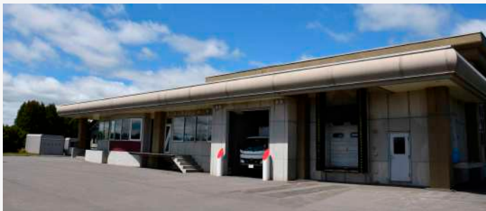
(給食センター外観)
