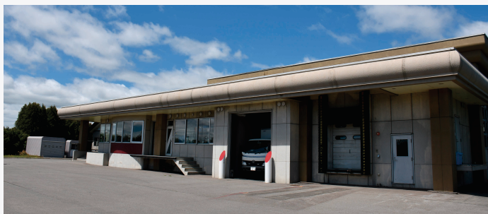
(給食センター外観)
