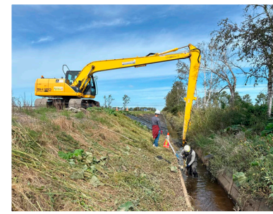
こぶし建設株式会社 馬淵建設株式会社 【西13号排水路堆積土砂撤去】
