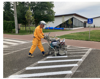
株式会社保工北海道 【中央公園駐車場区画線整備】
