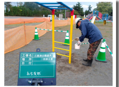
株式会社三建管工技研 【三重湖公園雲梯塗装】
