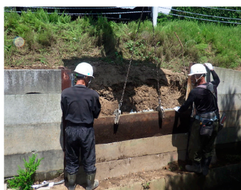
株式会社土井総業 【南13線排水路柵渠修繕】
