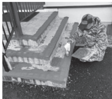
宮坂建設工業株式会社 【鶴城寿の家玄関タイル補修】
