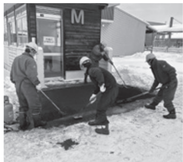
植村建設株式会社 【道営住宅各棟入口前舗装補修】
