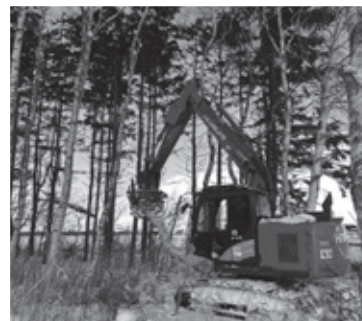
株式会社日栄建設 【南15線防風林内倒木処理】
