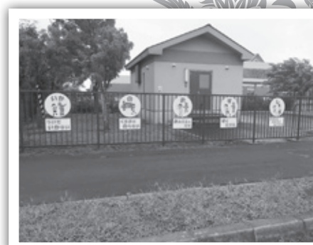
株式会社 北海道ロードサービス 南幌小学校子供用防犯標語看板設置
