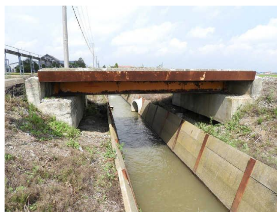
南 1 1 線西 7 号橋（橋長 5.4m） 昭和 48 年供用開始（49 歳）
