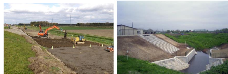
堤防整備 釜場整備
