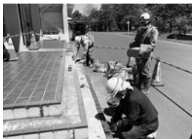
さくら佐藤建設株式会社 南幌中学校生徒玄関のタイル補修の様子
