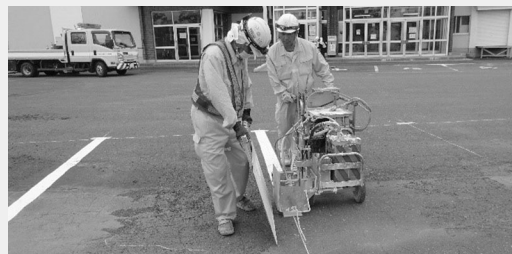
公共施設駐車場区画線塗装 (ぼろろ)
